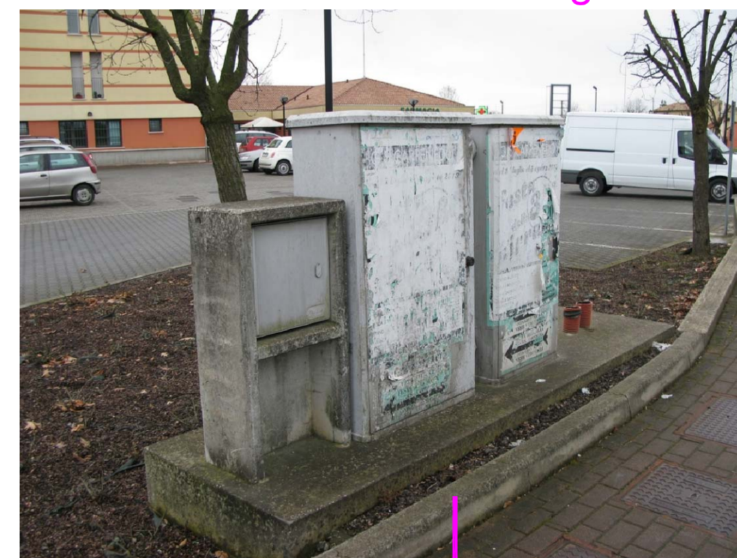
Quadro pubblica esistente alimentazione videosorveglianza
